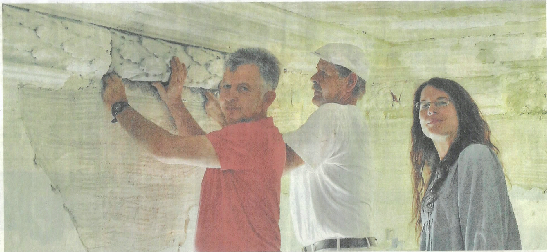
Schauen sich gemeinsam die Fortschritte bei der Stuck-Sanierung in der Kirche Gatzen an (v. l.): Rüdiger Brumme, Olaf Städter und Friederike Kaltoven.
